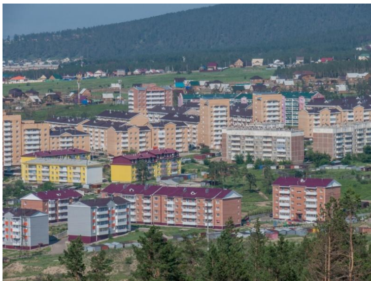
Рис. 4. Многоэтажное строительство в современном Улан-Удэ, 110–112 мкр., 2016
